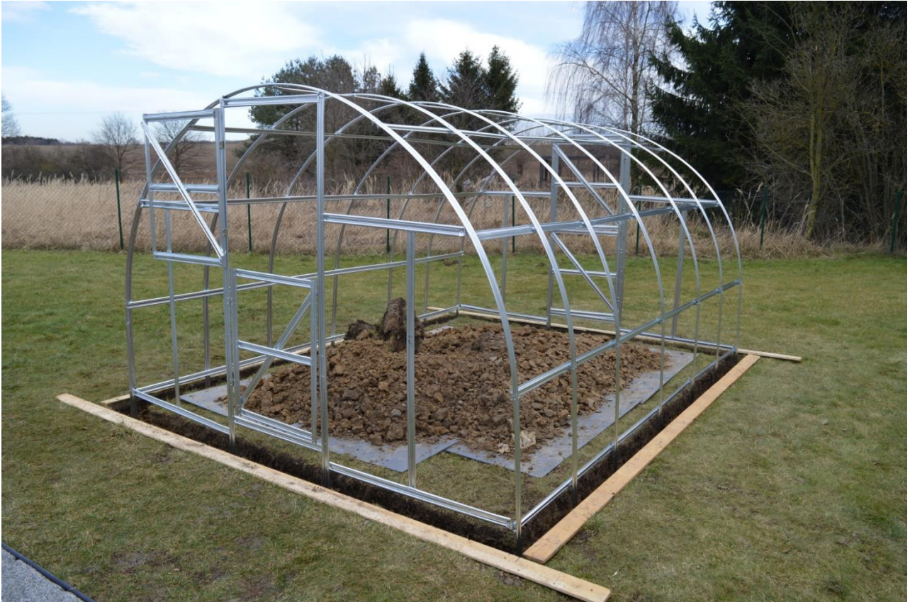
Tájékoztató ábra a KYKLOP 3x4 (2017-es modell) üvegház talajba rögzítésére (a profilok eltérők lehetnek, függően a modelltől, a gyártás évétől és az üvegház méretétől) a KYKLOP üvegház minden típusának azonos a talajba rögzítése
