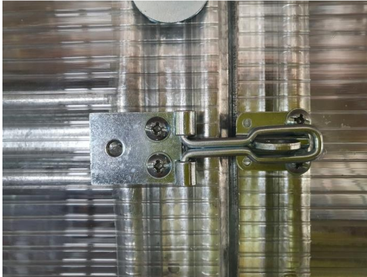
az üvegház és a polikarbonát lemez külső felére szerelt lakatpánt részlete
